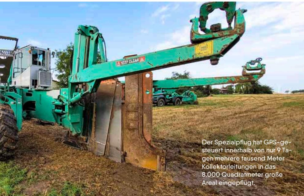
Der Spezialpflug hat GPS-gesteuert innerhalb von nur 9 Tagen mehrere tausend Meter Kollektorleitungen in das 8.000 Quadratmeter große Areal eingepflügt.
